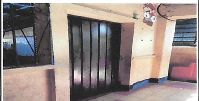
Foto 2: MÓDULO 2. Remozamiento de puertas en aulas y cambio de algunas chapas.
