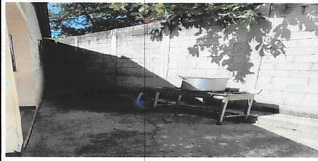
Foto 1: MÓDULO 1. Remozamiento de muro de cocina de mampostería y malla compuesta por cemento corrido y 5 hiladas de Block
