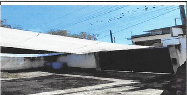
Foto 4: MÓDULO 4. sustitución de lona, por lámina troquelada de al zinc calibre 26.
